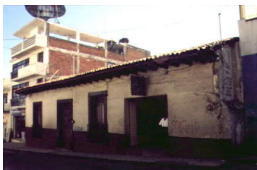
123 de 200 Casa-habitación Inmueble Casa-habitación I-0011604047, Ficha sin clasificación Michoacán de Ocampo, Uruapan, Uruapan Morelos
