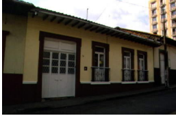
85 de 200 Casa-habitación Inmueble Casa-habitación I-0011603774, Ficha sin clasificación Michoacán de Ocampo, Uruapan, Uruapan 5 de Febrero Núm. ext. 58
