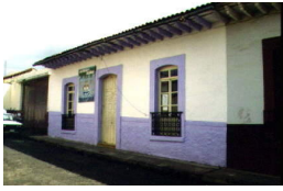
140 de 200 Casa-habitación Inmueble Casa-habitación I-0011603832, Ficha sin clasificación Michoacán de Ocampo, Uruapan, Uruapan Carrillo Puerto Núm. ext. 18
