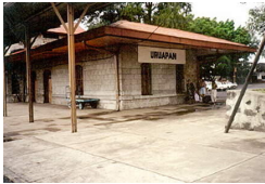
59 de 200 Estación Uruapan Inmueble Estación de Ferrocarril I-0011604058, Conjunto Arquitectónico Michoacán de Ocampo, Uruapan, Uruapan Paseo General Lázaro Cárdenas. Siglo XIX
