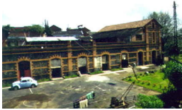
57 de 200 Casa-habitación Inmueble Casa-habitación I-0011604036, Conjunto Arquitectónico Michoacán de Ocampo, Uruapan, Uruapan Miguel Treviño
