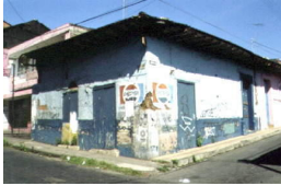
176 de 200 Casa-habitación Inmueble Casa-habitación I-0011604114, Ficha sin clasificación Michoacán de Ocampo, Uruapan, Uruapan Pradera
