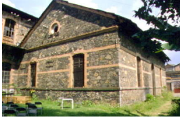
56 de 200 Sub-estación eléctrica Inmueble Sub-estación eléctrica I-0011604035, Conjunto Arquitectónico Michoacán de Ocampo, Uruapan, Uruapan Miguel Treviño
