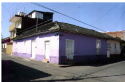
146 de 200 Casa-habitación Inmueble Casa-habitación I-0011603838, Ficha sin clasificación Michoacán de Ocampo, Uruapan, Uruapan Colón Núm. ext. 22
