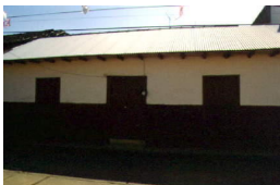
145 de 200 Casa-habitación Inmueble Casa-habitación I-0011603837, Ficha sin clasificación Michoacán de Ocampo, Uruapan, Uruapan Colón Núm. ext. 17
