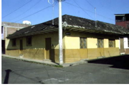
148 de 200 Casa-habitación Inmueble Casa-habitación I-0011603840, Ficha sin clasificación Michoacán de Ocampo, Uruapan, Uruapan Colón Núm. ext. 34
