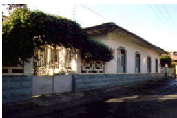
149 de 200 Casa-habitación Inmueble Casa-habitación I-0011603841, Ficha sin clasificación Michoacán de Ocampo, Uruapan, Uruapan Colón Núm. ext. 38
