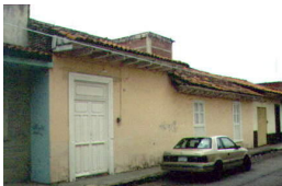
184 de 200 Casa-habitación Inmueble Casa-habitación I-0011604122, Ficha sin clasificación Michoacán de Ocampo, Uruapan, Uruapan Reforma Núm. ext. 20
